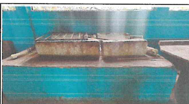
Foto 6: Sustrucción de estufa rural con plancha de 3 hornillas e implementación de azulejo y chimenea en cocina
