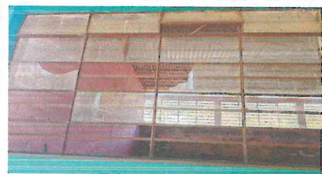
Foto 3: Sustrucción de ventana de metal por ventana de pvc en salón de clases
