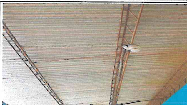
Foto 1: Sustrucción de lámina acanalada por lámina troquelada en salón de clases
