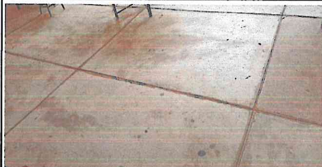
Foto 4: Sustrucción de piso de concreto por piso cerámico en salón de clases y corredor
